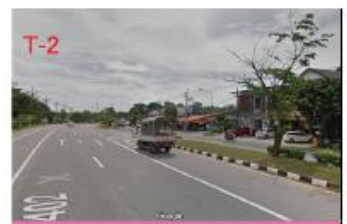
ทางลอด กม. 16+547 (บริเวณโรงเรียนห้วยทอขบ่ารุง)
