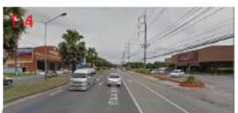
ทางลอด กม. 26+237 (บริเวณสวนคุณแม่ปู้)
