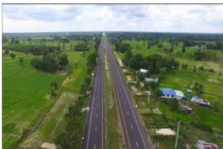
โครงการก่อสร้างทางหลวงหมายเลข 24 สาย แยกบ้านจาน – อ.เดชอุดม ตอน 2
