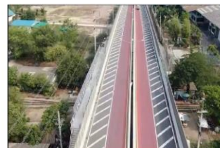
สะพานข้ามจุดตัดทางรถไฟทางหลวงชนบทสาย ศก.4003 แยก ทล.2076 – บ้านห้วยทับทัน
