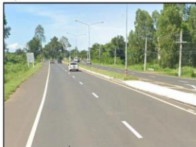
โครงการก่อสร้างเพิ่มช่องจราจร ทล.2085,2178 แยกทางหลวงหมายเลข 24 – อูบลราชนาณี
